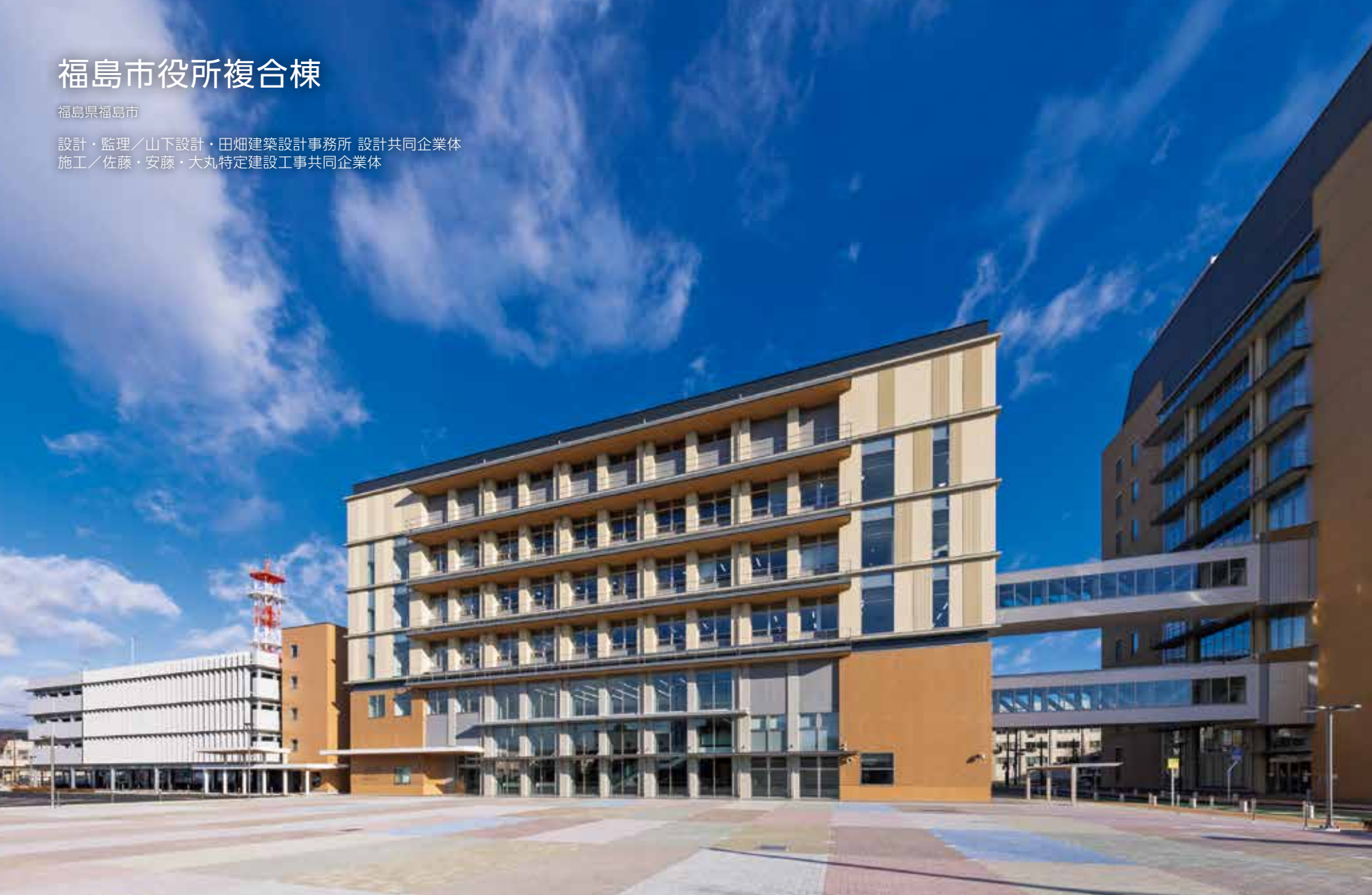
複合棟南東側外観 複合棟前の市民広場は駐車場としても機能する
