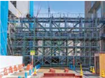
連絡通路_鉄骨建方
