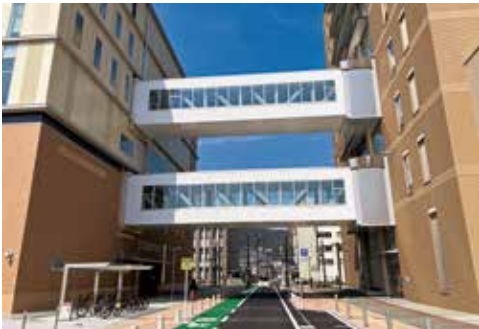
免振構造同士の建物をつなぐ連絡通路(写真提供：山下設計)
