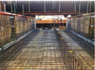
共同溝_施工中
