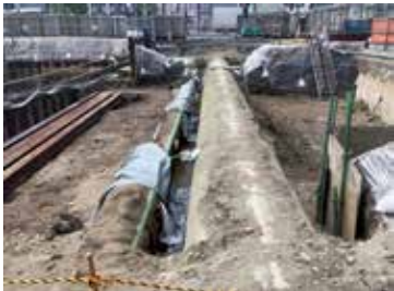
下水道本管切り回し前
